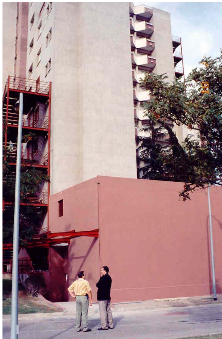
Planta térmica (calefacción-ACS) con biomasa. 1MWth. Movera (Zaragoza)
