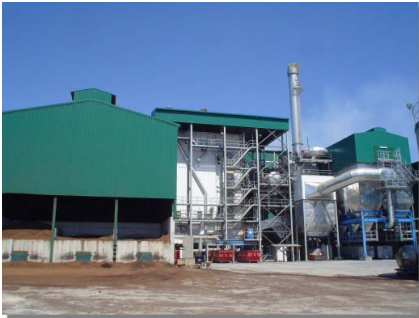
Planta de generación eléctrica con orujillo de Extragol. 8,7 MW. Foto: VALORIZA.
