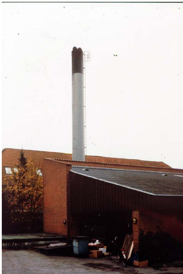
Planta centralizada de calefacción con biomasa en Dinamarca(400 KWth)
