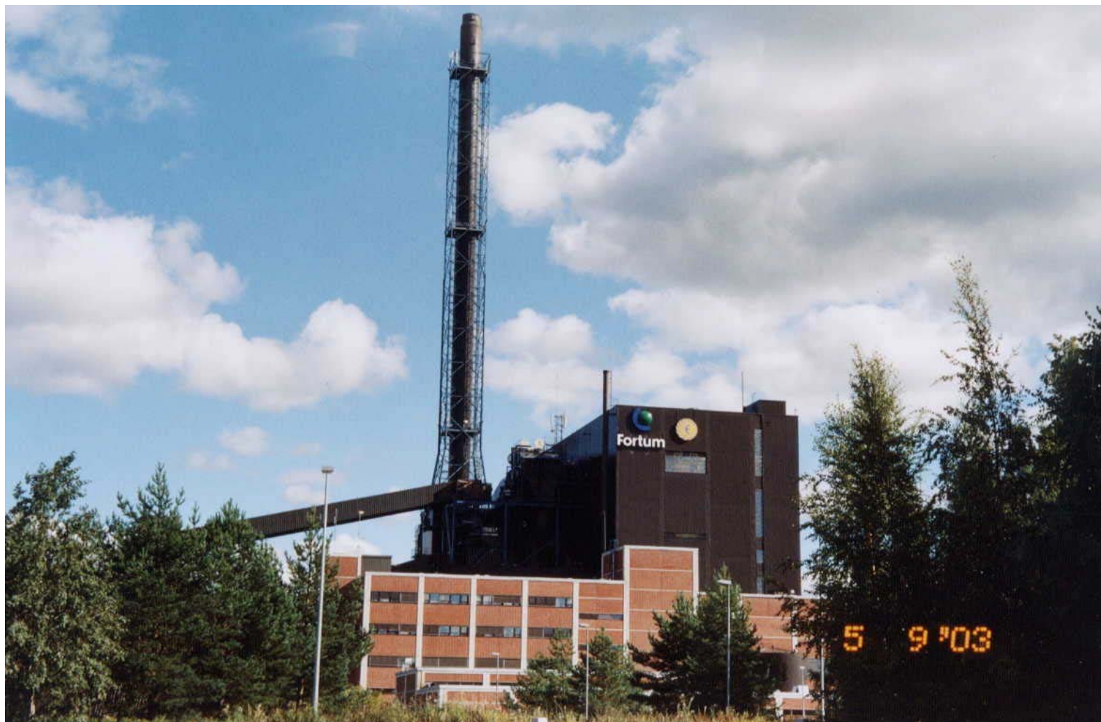
Planta de generación de electricidad multibiomasa en Finlandia. 50 MWe
