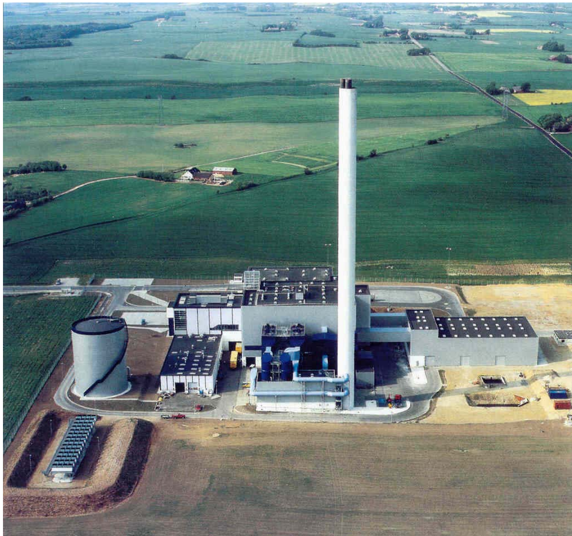
Central térmica multicombustible de Maajvaert. 50MW
