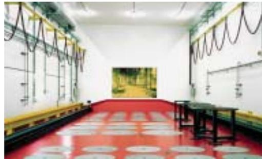
Figura 5.17. Instalaciones de tipo bóveda para almacenamiento temporal de combustible gastado. Arriba, Fort St. Vrain (Colorado, EE.UU.) y CASCAD (Cadarache, Francia). Segunda línea: Paks (Hungría). Abajo: HABOG (Borssele, Holanda).
