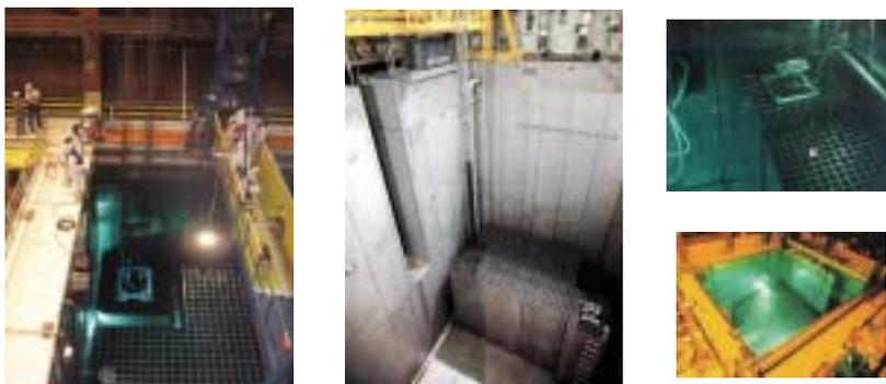
Figura 5.9. Instalación de bastidores para alojamiento del combustible gastado en piscinas.
